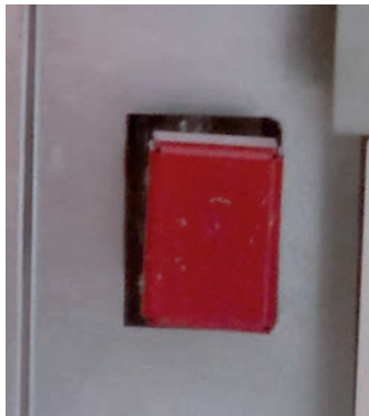
Pulsador manual para limpieza automática de intercambiadores
